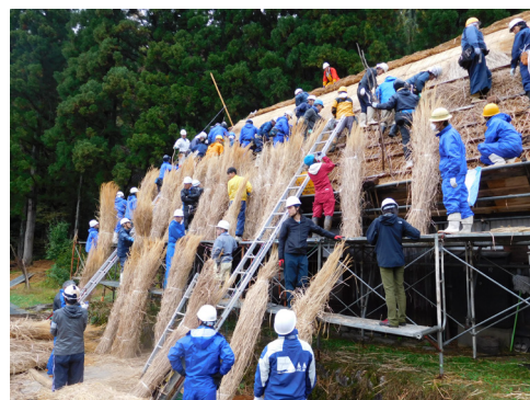
＜白川郷合掌造民家の屋根の葺き替え＞
